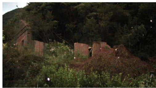
写真5-2-1-2 桐古天主堂改修後の煉瓦の遺構
