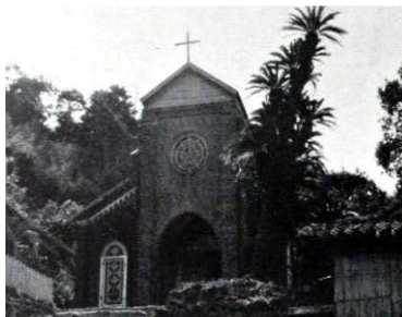
写真5-2-1-1 改修後の桐古天主堂 (岩波ブックレットより転載)
