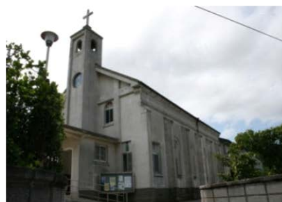
写真3-4-17 塔増築工事後の山田天主堂
