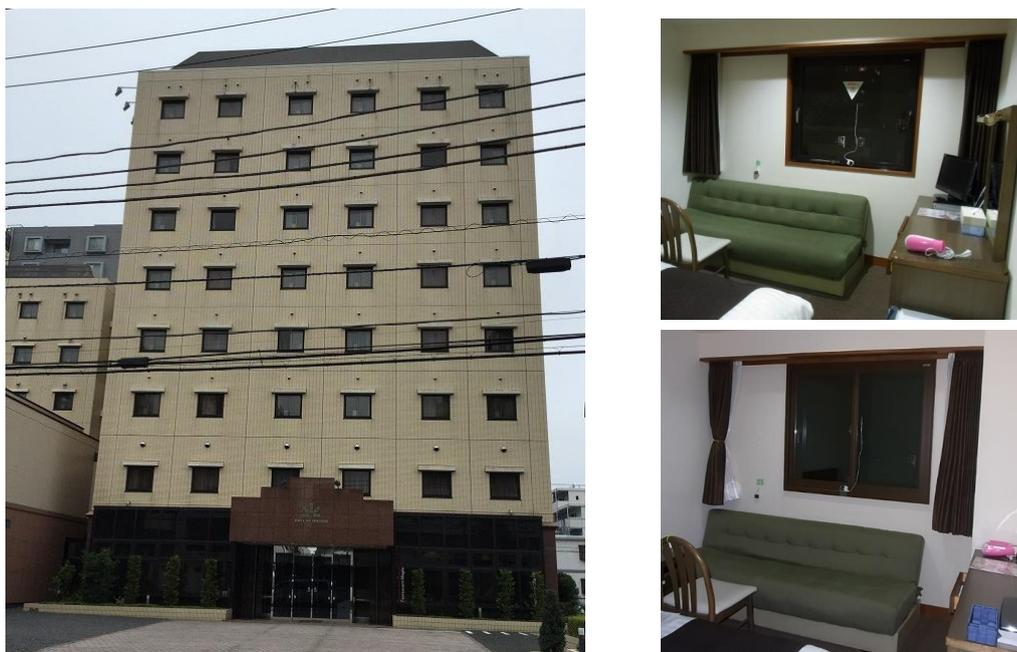
図2-3 ホテルAの外観(左)と既存客室のアルミ枠窓(右上)と内窓(右下)
