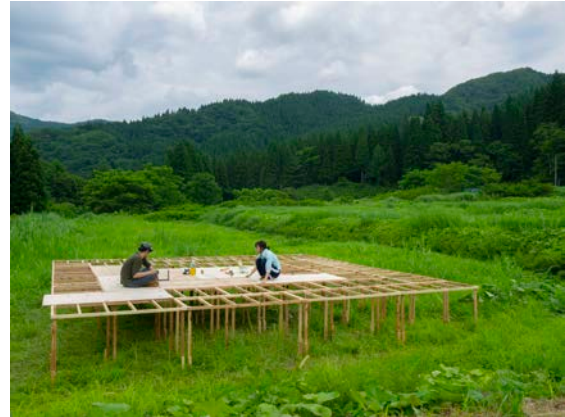
図 7-26 制作風景 床板張り
