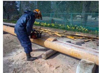
図7-20 座面の切り出し
