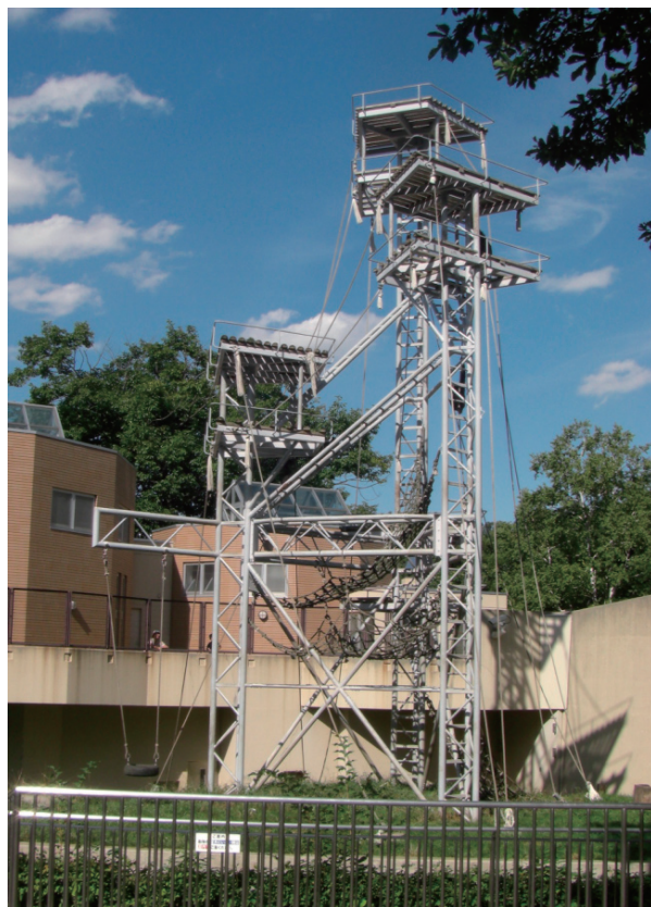
図7 タワー写真(動画撮影方向より)
