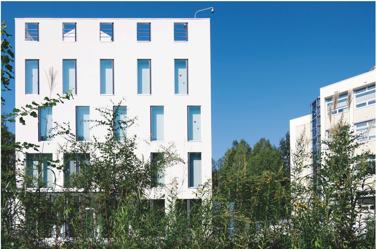
東側立面，3，4階は同様の空間であるが，窓の位置がずれている．専攻科との間に中庭がある．
