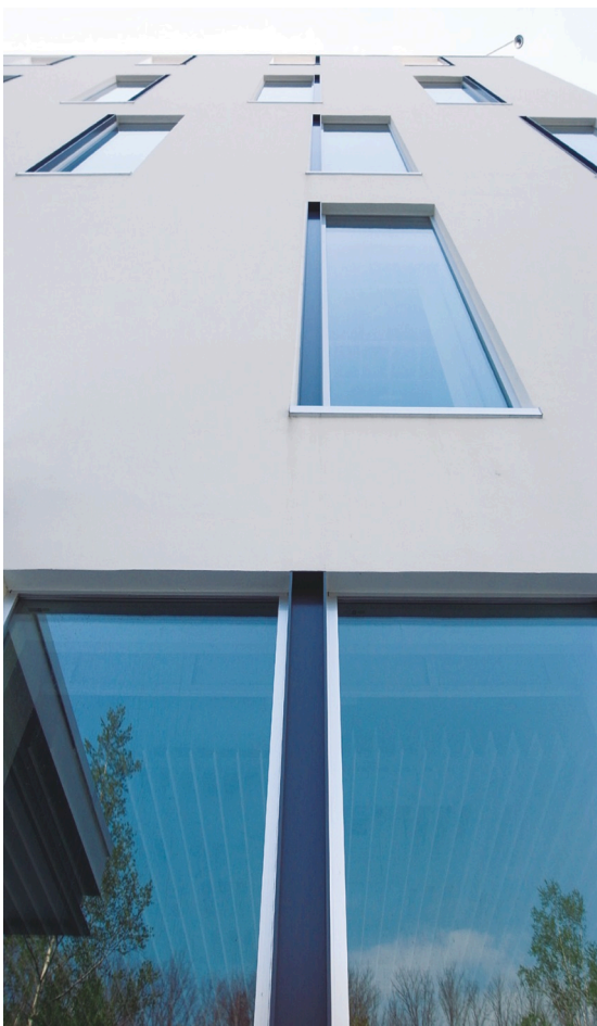
外壁を構成する窓とグレーの溝型ピラスター
